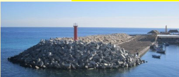
Protection par enrochements et acropodes
