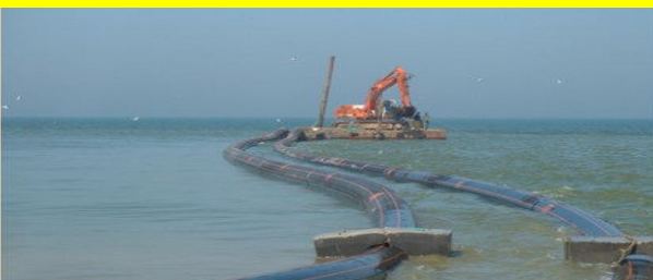
Pose conduites immergées
